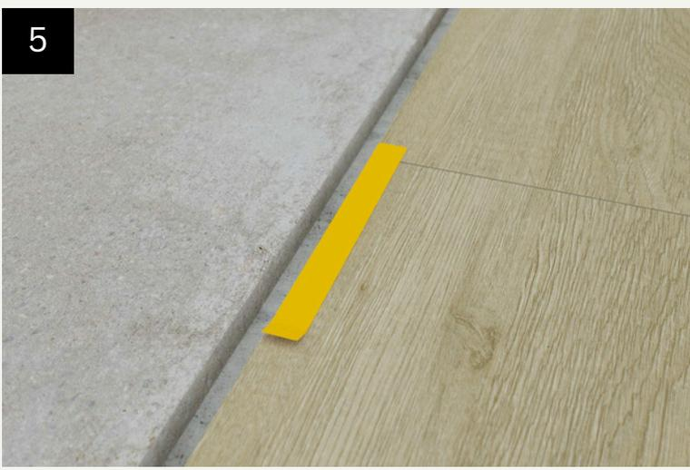
Die einzelnen Klebestripes werden vom Klebebogen abgezogen (Abzuglasche beachten) und einseitig zur langen Seite hin bündig mit der Kante der Übergangsfuge auf den Bodenbelag geklebt. **Der Bodenbelag muss staub-, fettfrei und trocken sein. Ggf. vor Montage reinigen. Ideale Verlegetemperatur von +15°C bis +30°C.**
