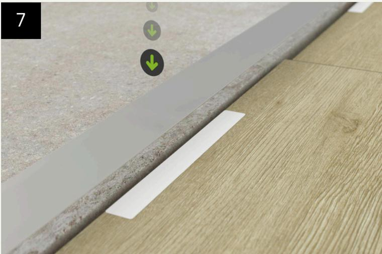
Nun kann das Übergangsprofil einfach auf die Klebestripes aufgeklebt werden. Die korrekte Positionierung ist wichtig, da nach dem ersten Klebestripe die Leiste nicht mehr parallel zur Übergangsfuge verschoben werden kann.
